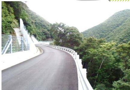
④付替市道(右岸下流部)
