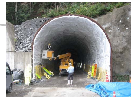
⑤一生原トンネル
