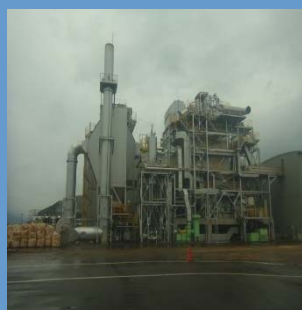
発電施設全景（H27年2月操業）
