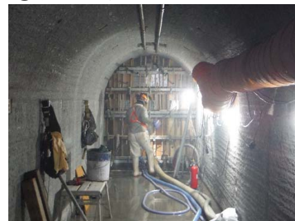
②堤内仮排水路閉塞
