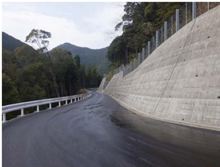
③付替市道(左岸上流部)
