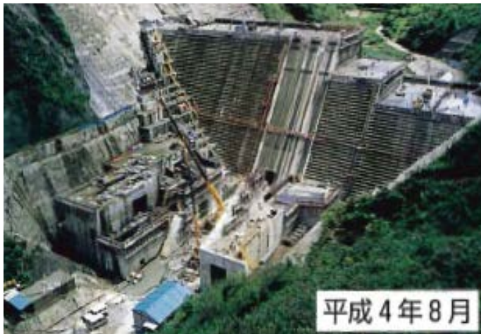
ダム本体コンクリート打設
