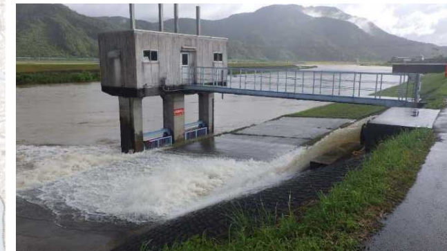
写真：楠島地区(清水樋門)における排水ポンプ車(150m 3 /min)による排水作業
