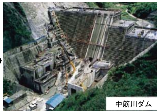
本体コンクリート打設(イメージ)
