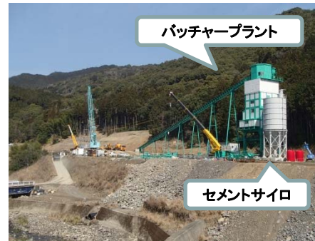
コンクリート仮設備設置状況(写真③)
