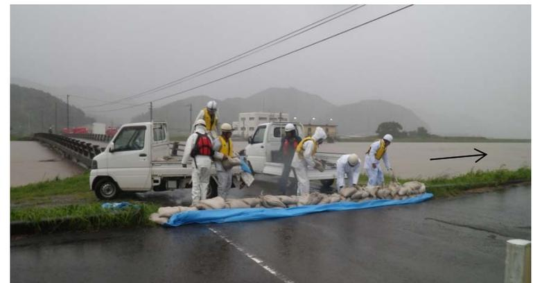
有岡箇所(中筋川)での水防活動状況[土のう積み工]
