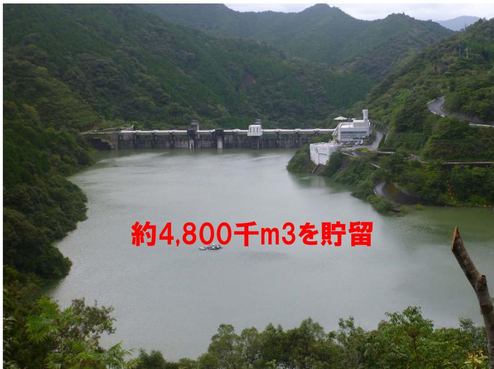
中筋川ダムの防災操作前の貯水位  $H=72.1\text{m}$
