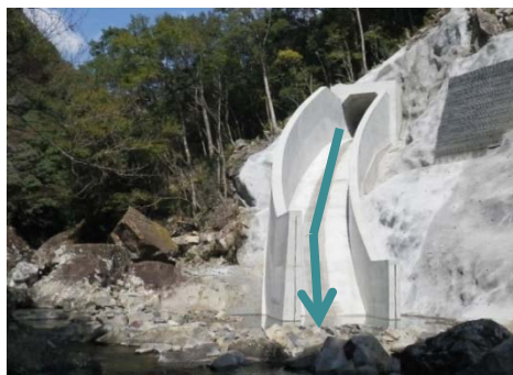
仮排水トンネル吐口(写真②)
