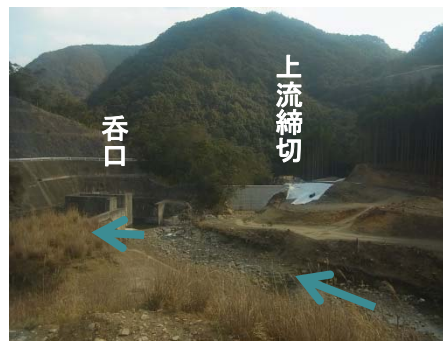
貯水池上流からの上流仮締切、 仮排水トンネル呑口(写真③)
