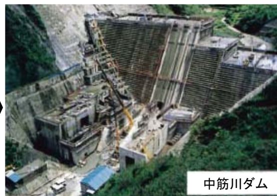
本体コンクリート打設(イメージ)
