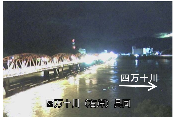
洪水ピーク時の状況(四万十川橋)
