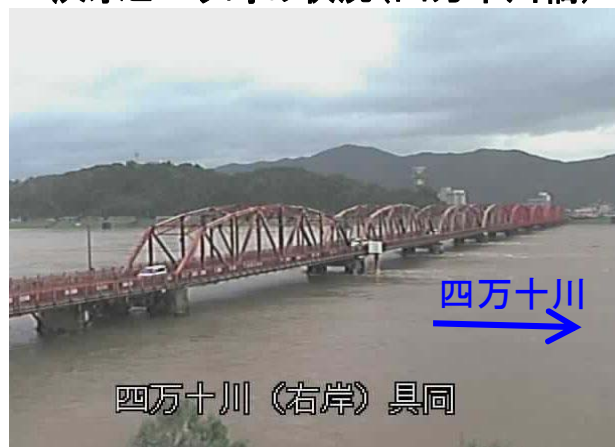
洪水ピーク時の状況(四万十川橋)
