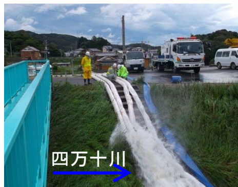
不破下流樋門
