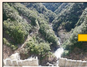
↑整備前の写真 (ダムの上から)
