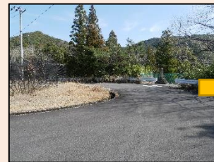
↑整備前の写真 (ダムの建設中に見学所が あったところ)
