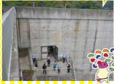
装置に破損などの異常 がないか確認中
