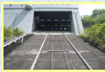
左場所の拡大図(下から撮った写真)頑丈なロープで自動でボートを昇降させるんだ。
