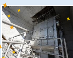
下段ゲートの扉体
