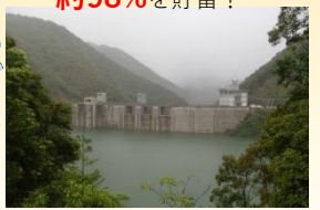
貯留後 最高貯水位EL=134.30m (6月3日0時30分)
