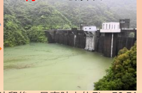
貯留後 最高貯水位EL=78.71m (6月3日0時40分)
