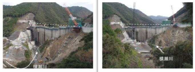
コンクリートの打設は、高さ72.1mのうち62.0m(全体コンクリート量の約94%)まですすんでいます。
