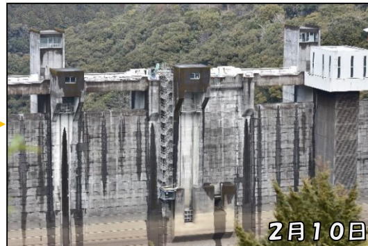
工事の進捗状況
