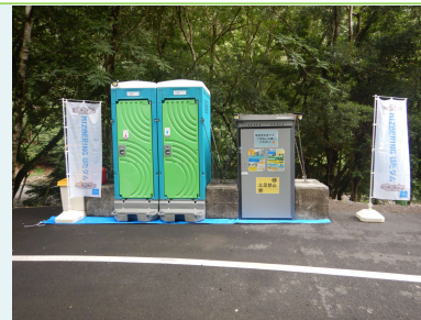
仮設トイレ・簡易更衣室
