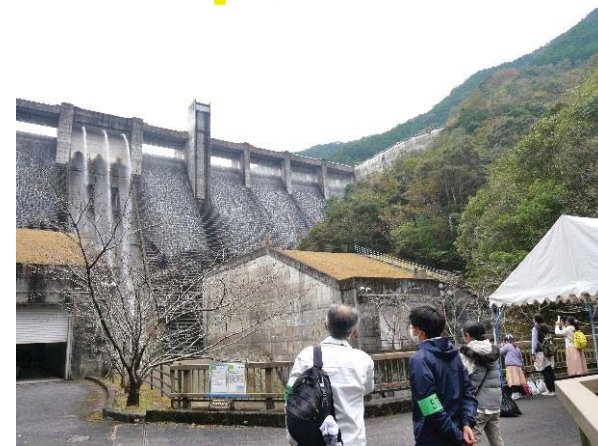
洗浄放水を見学！
