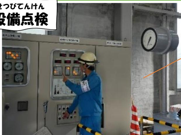
操作盤の表示灯や計器類が正しく動作しているか目視で確認しています。
