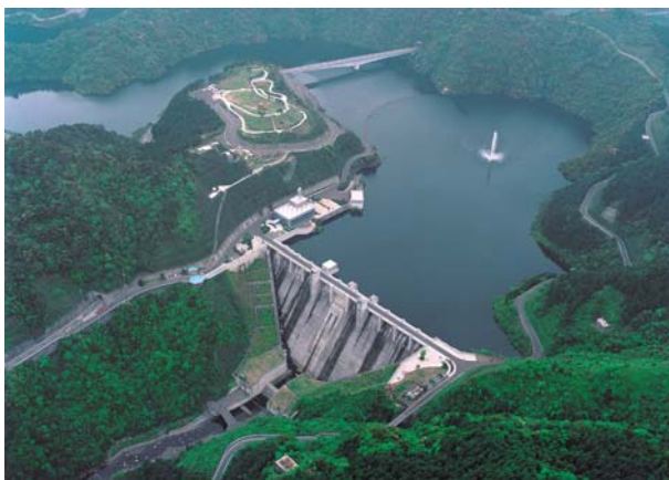
写真－1 中筋川ダム
