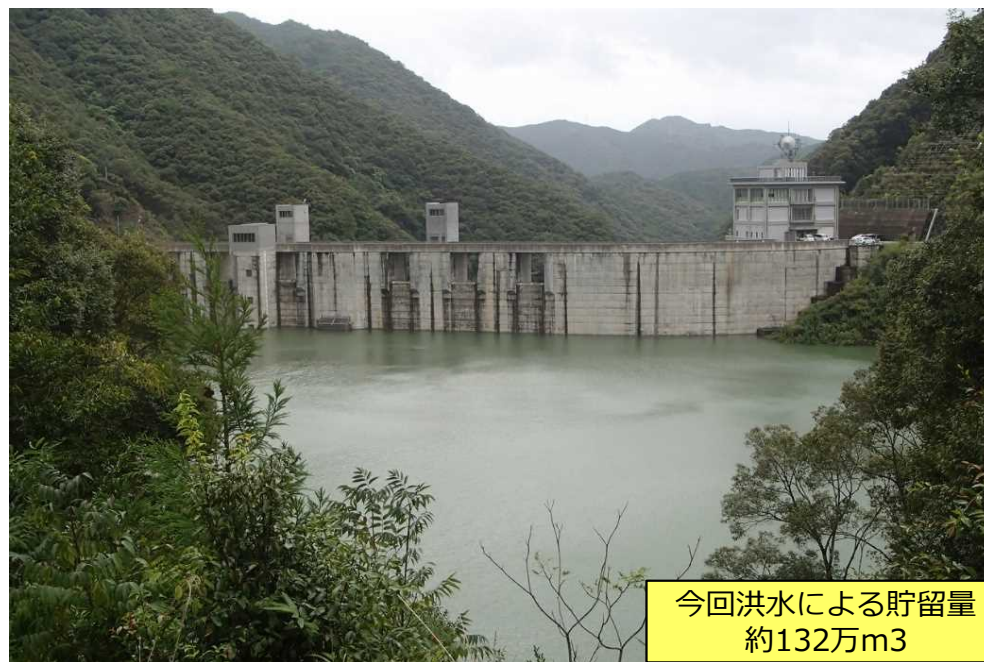
貯留後 最高貯水位EL=135.78m (8月29日9時20分)
