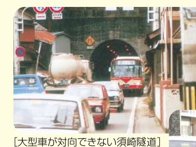
[大型車が対向できない須崎隧道]
