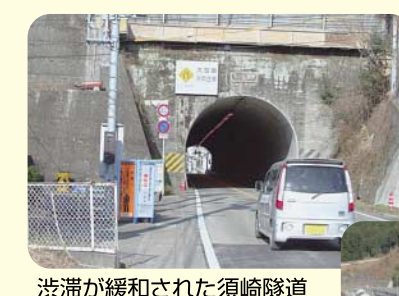
渋滞が緩和された須崎隧道
