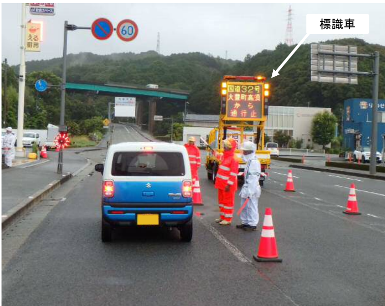
【標識車】 令和6年8月 国道32号_台風10号による通行規制に 伴う案内状況 [ 高知県南国市領石 ]
