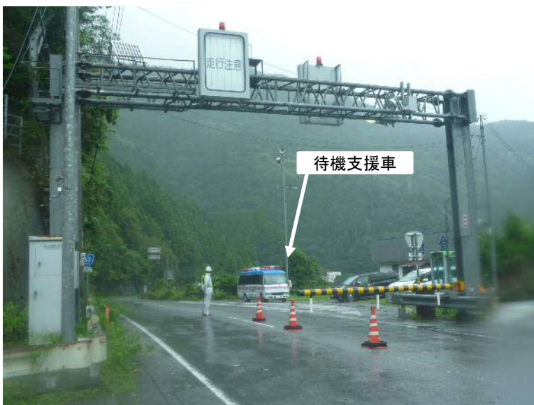
【待機支援車】 令和6年8月 国道33号_台風10号による通行規制 状況 [ 高知県吾川郡仁淀川町森山 ]
