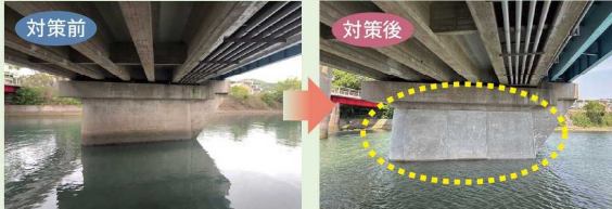
国道55号 豊栄橋における橋脚巻立て
