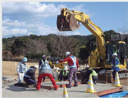
橋梁段差の応急復旧訓練
