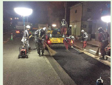
路面の舗装・補修
