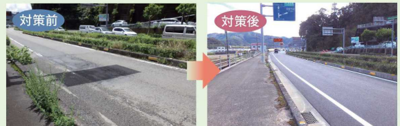
国道56号 須崎市におけるアスファルト舗装修繕
