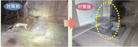
国道32号 高知橋における支承取替
