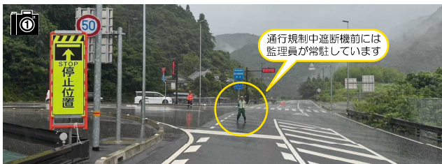
大雨時通行規制(越知町起点)
