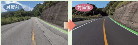
国道55号 東洋町におけるアスファルト舗装修繕
