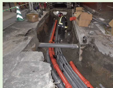
電線地中化作業状況
