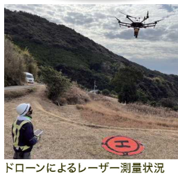
ドローンによるレーザー測量状況
