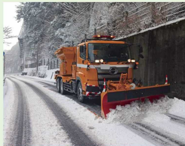
道路の除雪作業
