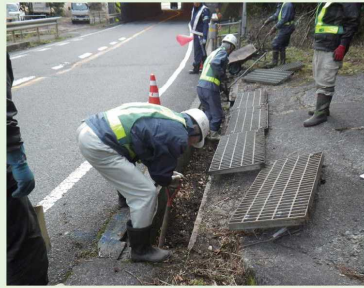
道路側溝の清掃
