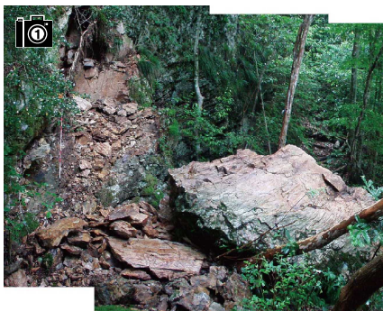
亀裂が発達し剥離した岩塊
