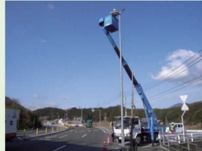
道路照明灯のランプ球替え
