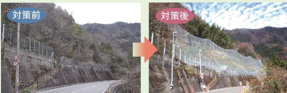
国道33号 仁淀川町鷺ノ巣におけるポケット式落石防護網工
