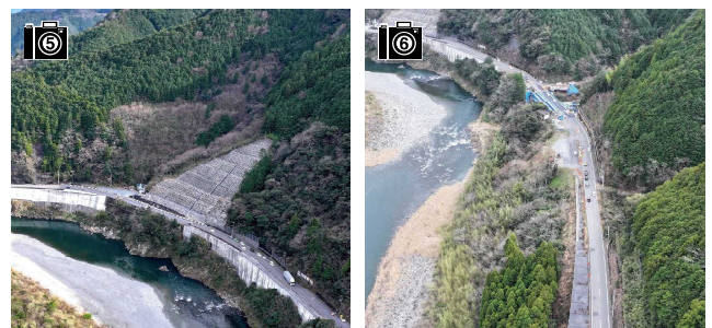
現道活用区間(越知道路(2工区)):R8.3.10撮影
