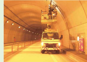
トンネル照明のランプ球替え
