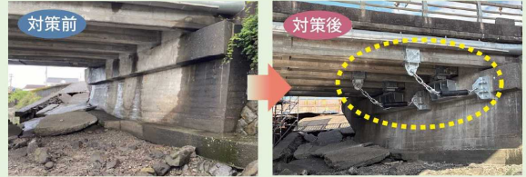
国道55号 豊栄橋における落橋防止
