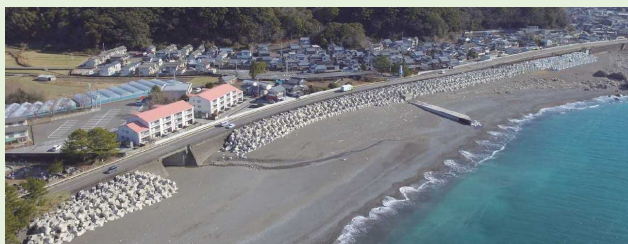
国道55号 安田町安田海岸における消波ブロック工
