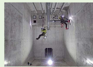
橋梁点検（箱桁内）
