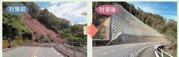
国道56号 中土佐町における災害復旧工事
