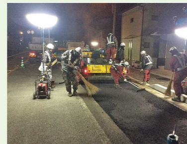
路面の舗装・補修
