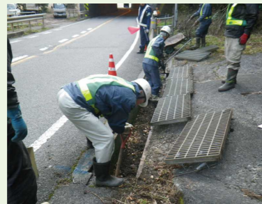
道路側溝の清掃
