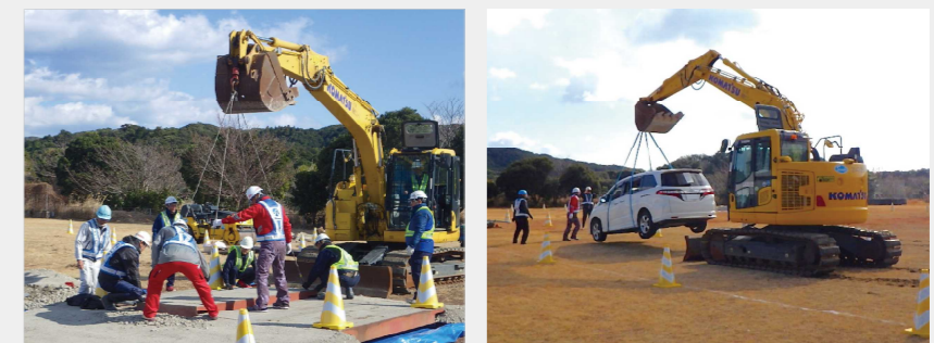
橋梁段差の応急復旧訓練 バックホウによる車両移動訓練
