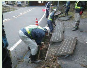
道路側溝の清掃
