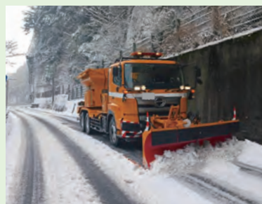
道路の除雪作業
