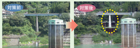
国道33号 湊溜橋における橋脚巻立て
