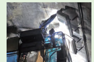
トンネル点検
