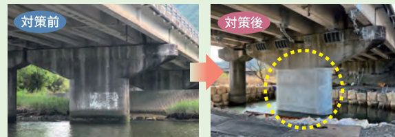
国道56号 新荘川橋における橋脚巻立て及び落橋防止
