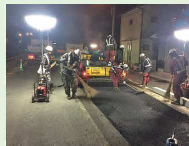
路面の舗装・補修
