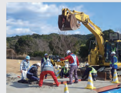
橋梁段差の応急復旧訓練
