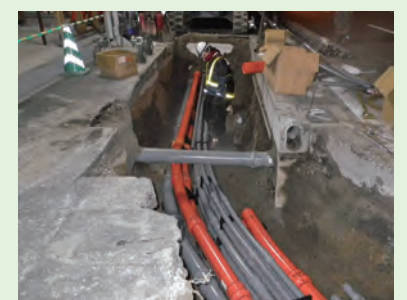
電線地中化作業状況
