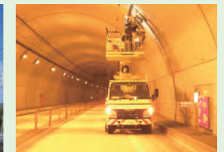
トンネル照明のランプ球替え
