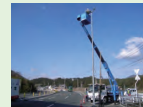
道路照明灯のランプ球替え
