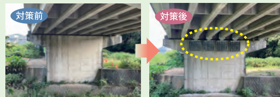
国道32号 新領石橋における水平力分担構造取付
