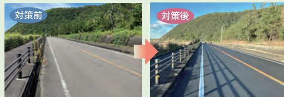
国道55号 室戸市におけるアスファルト舗装修繕
