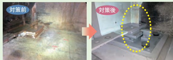
国道32号 高知橋における支承取替
