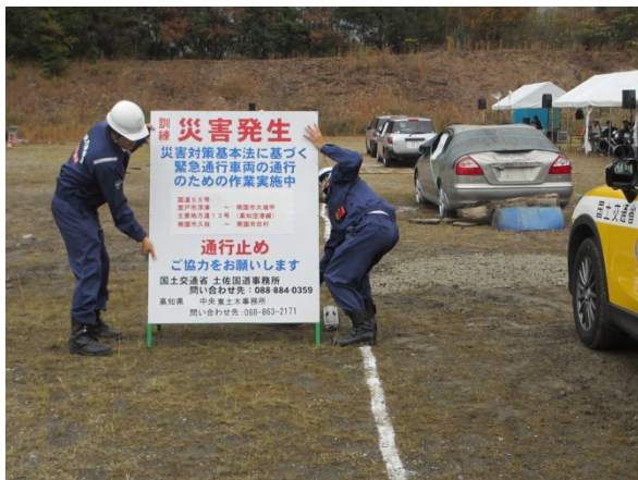
道路区間指定の周知看板を設置
