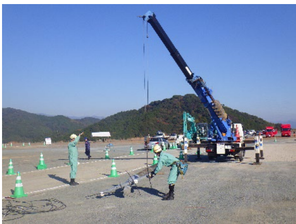
倒壊電柱撤去
