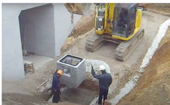
作成した集水柵の据付の様子
