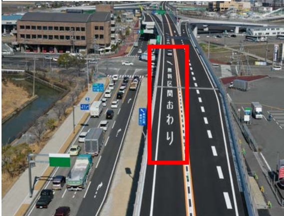
自動車専用道路での路面標示
