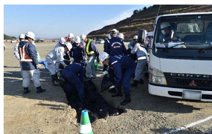
土佐国道、高知県の若手職員参加の路面復旧訓練 土のう作りから、積みまでを実体験。
