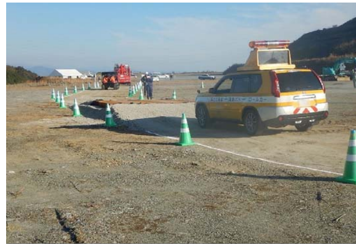
啓開完了後の緊急車両の通行。
