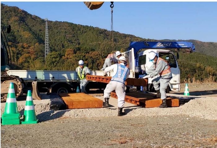
路面の段差を覆工板により解消。
