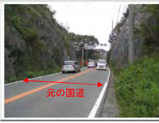
道路幅員が狭いうえに、道路横の斜面勾配が急なため、落石災害の危機があります。
