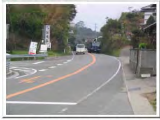
縦断勾配が急な上にS字カーブの道路形状であるため、見通しが悪くなっています。
