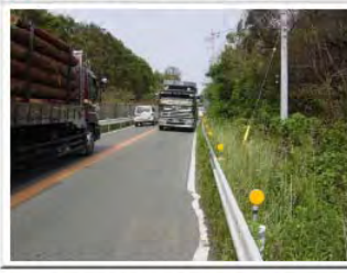
路肩が狭いため、歩行者・自転車の通行は非常に危険を伴います。
