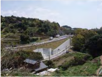
手結山トンネル付近より工事が進んでいます。
