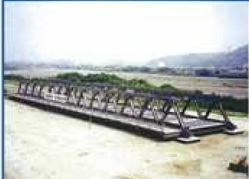
応急組立橋(トラス)車線30m
