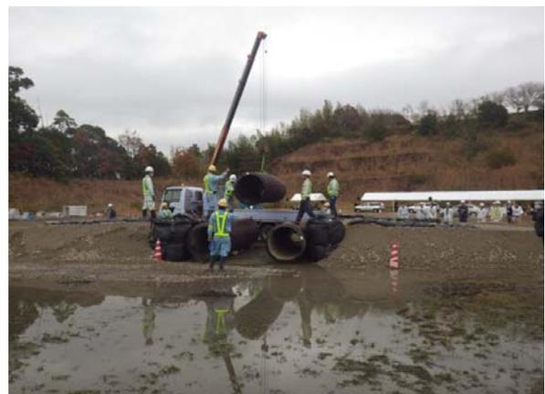
【落橋箇所の応急復旧(コルゲートパイプ設置)】
