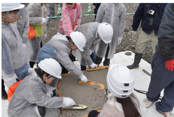
固まる前のコンクリートの表面を平らにします。 将来有望な子どもたちも多かった・・・！？
