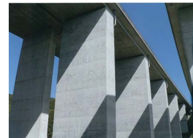
コンクリート巻き立て 施工完了
