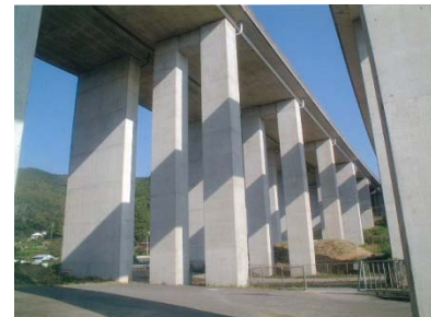
コンクリート巻き立て 施工前
