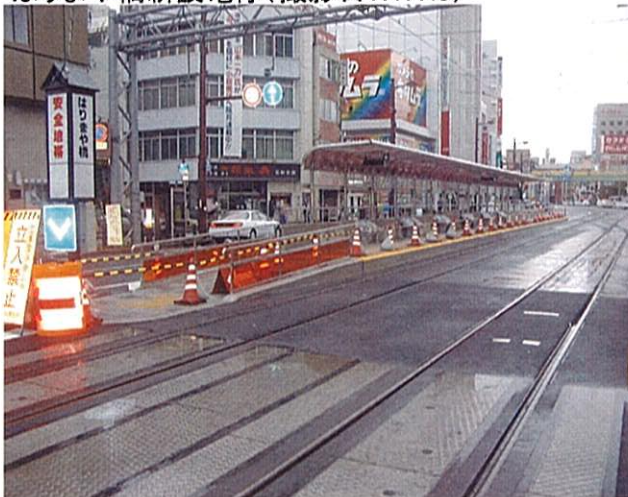
はりまや橋新設電停(撮影日:H17.3)
