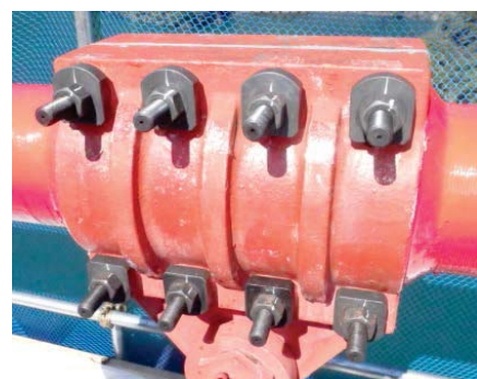
ボルト交換完了
