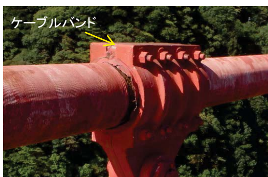
ボルト交換施工前
