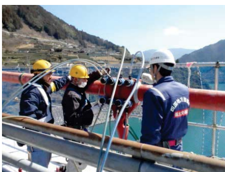
ボルト交換（軸力導入状況）
