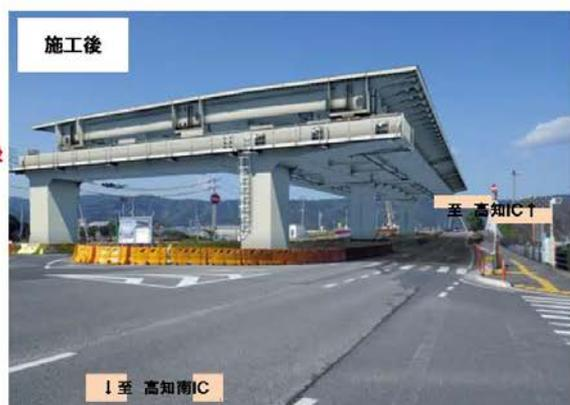
規制開始後、橋桁を運搬させ、基礎と連結するまで、約10時間の作業で翌日の朝には橋梁架設が完了しています。
