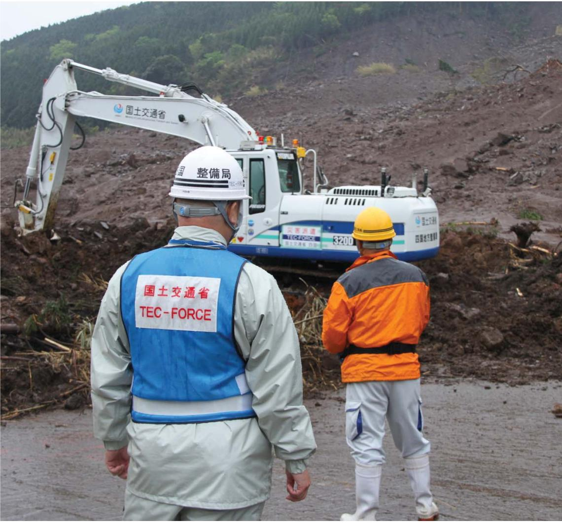
遠隔操縦式バックホウによる土砂撤去作業
