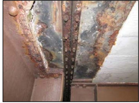
鋼材の腐食
