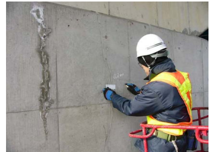
目視によるひび割れ点検
