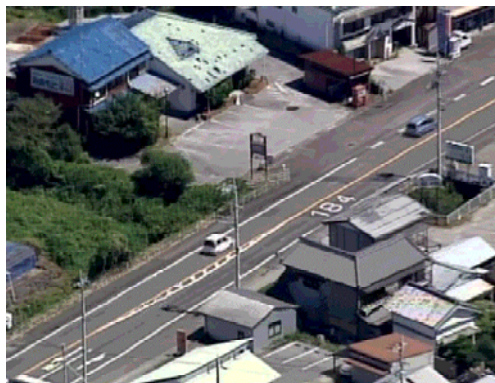
※上空約600mからの視認状況
