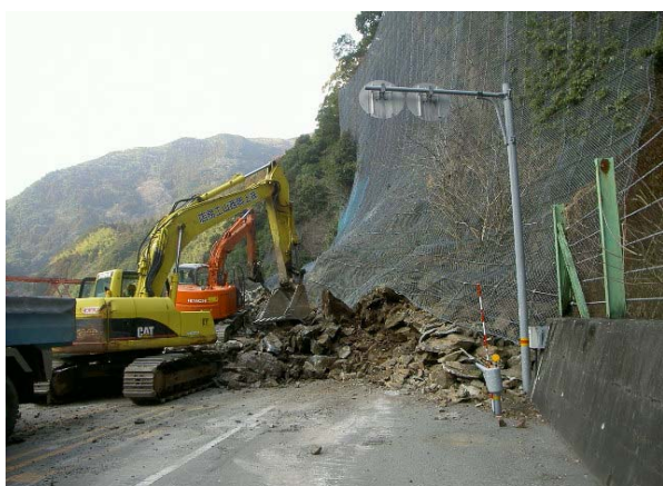
【高知県側作業状況】
