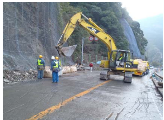
【大型土嚢設置】
