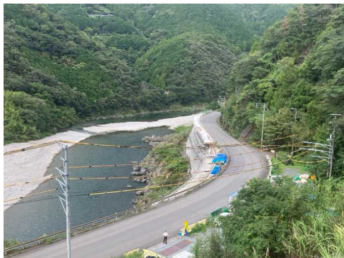
起点側工区（撮影方向：南東向き）
