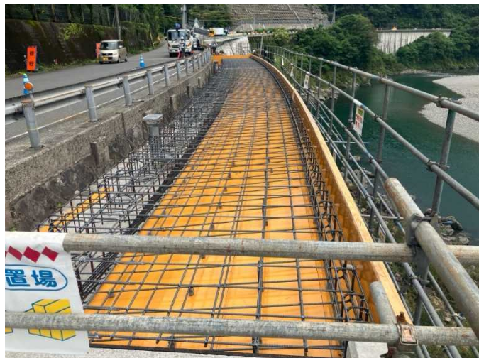
起点側工区（撮影方向：北西向き）
