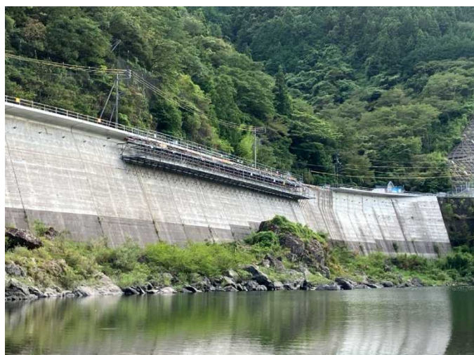
起点側工区（撮影方向：北向き）
