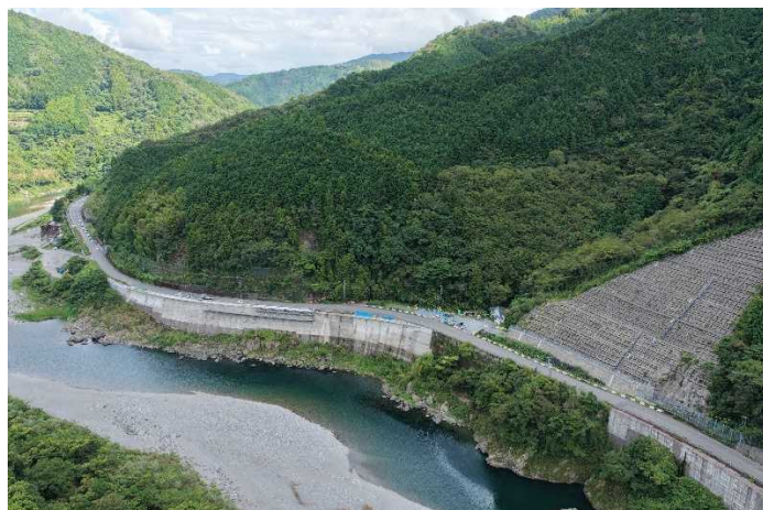
起点側工区（撮影方向：南西向き）
