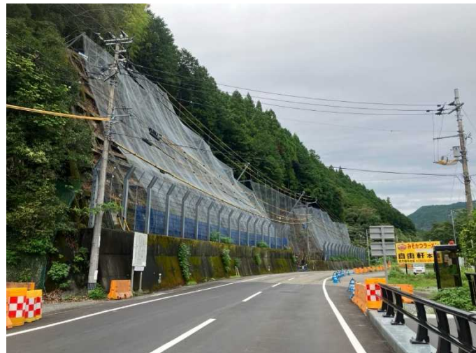
終点側工区（撮影方向：北西向き）
