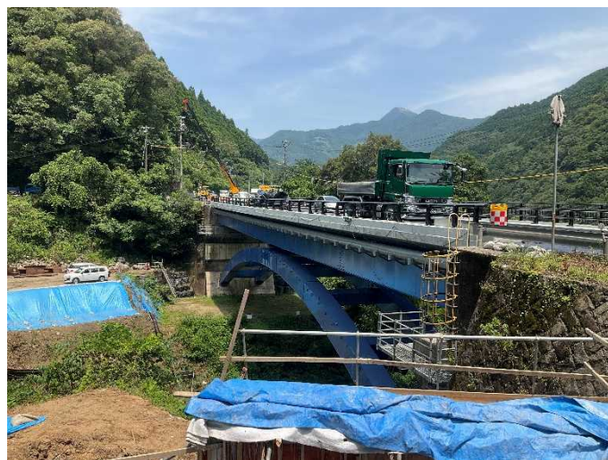
A 2 橋台側（撮影方向：北西向き）
