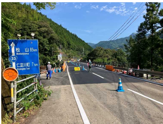
A 1 橋台側(撮影方向：南東向き)
