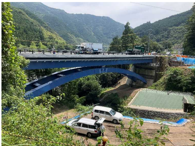
A 1 橋台側（撮影方向：南東向き）
