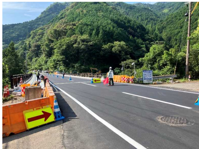
A 2 橋台側（撮影方向：北西向き）
