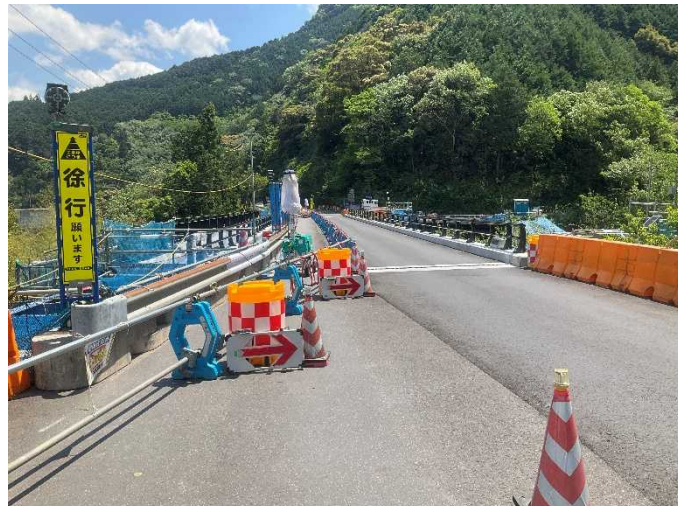
A 2 橋台側（撮影方向：北西向き）
