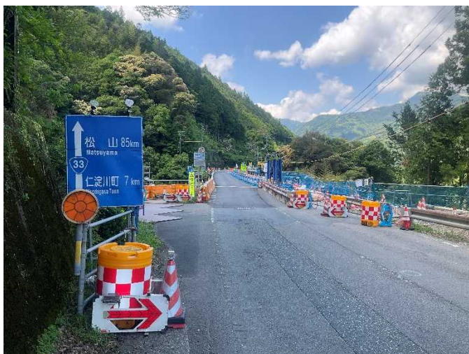
A 1 橋台側(撮影方向：南東向き)
