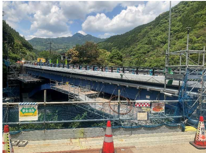
A 2 橋台側（撮影方向：北西向き）
