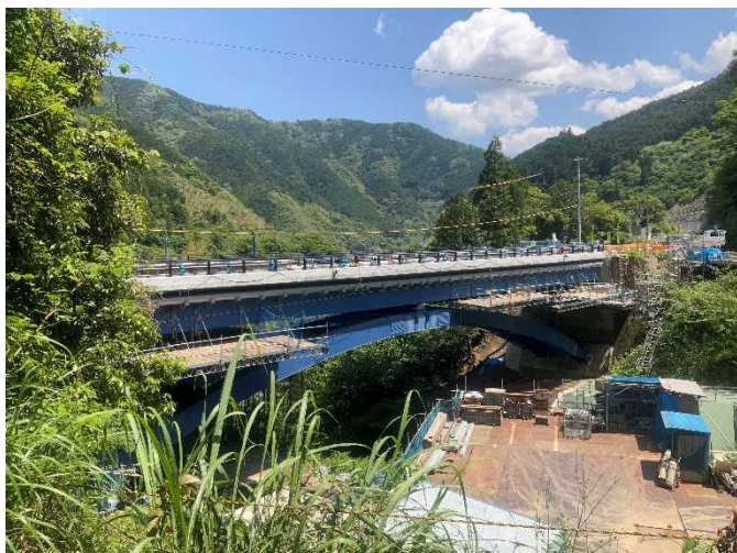
A 1 橋台側（撮影方向：南東向き）
