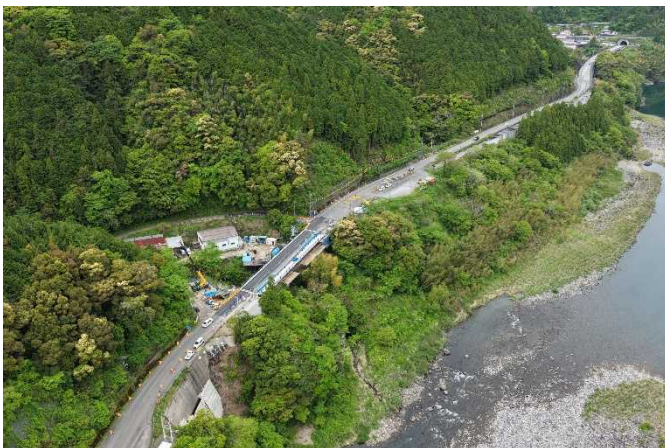
起点側工区（撮影方向：北向き）
