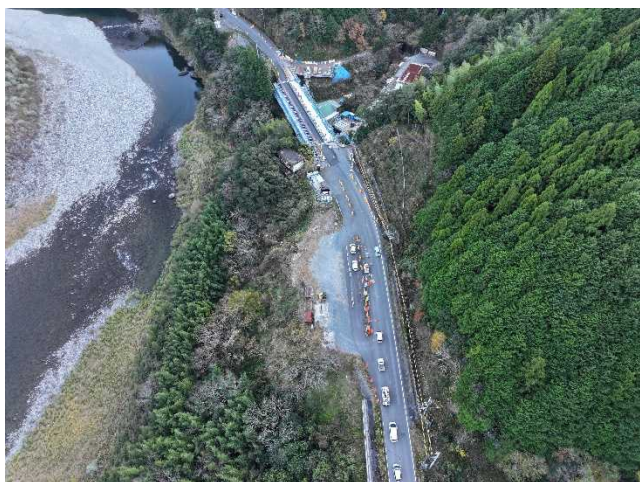
起点側工区（撮影方向：南向き）
