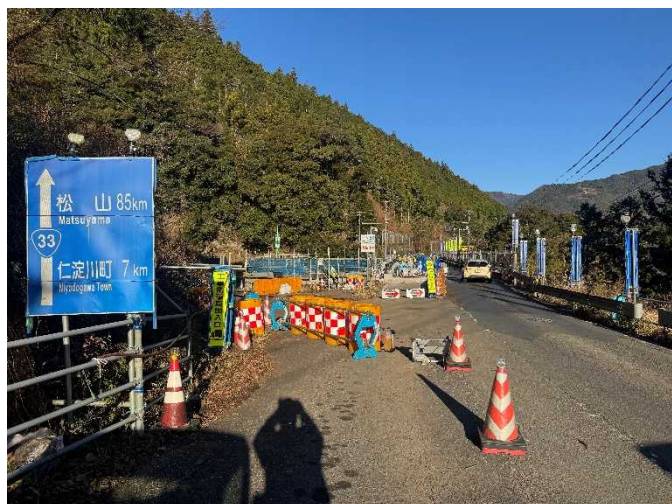
A1 橋台側(撮影方向：南東向き)
