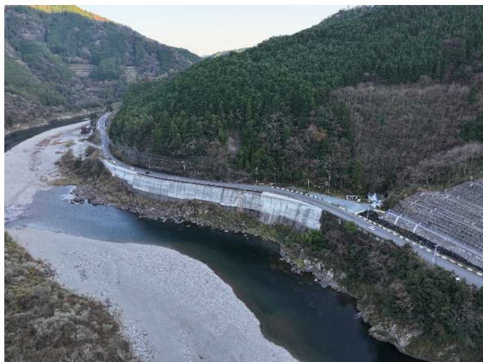
起点側工区（撮影方向：南西向き）
