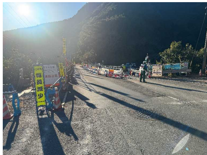
A2 橋台側(撮影方向：北西向き)
