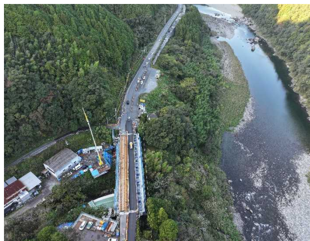
終点側工区（撮影方向：北向き）
