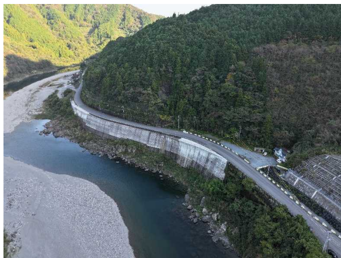
起点側工区（撮影方向：南西向き）
