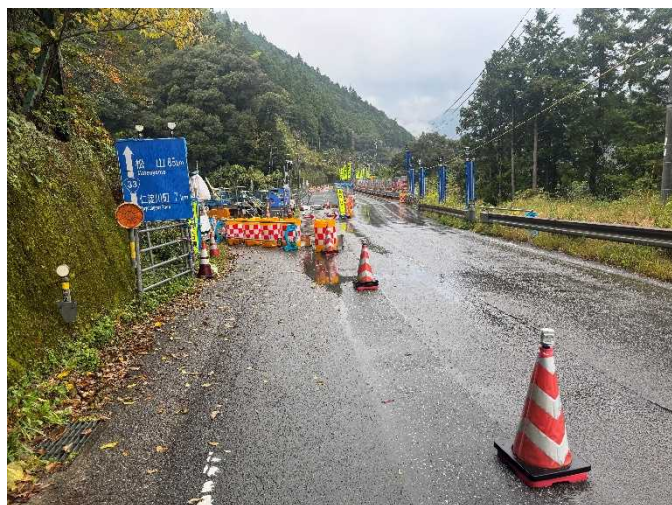
A 1 橋台側(撮影方向：南東向き)
