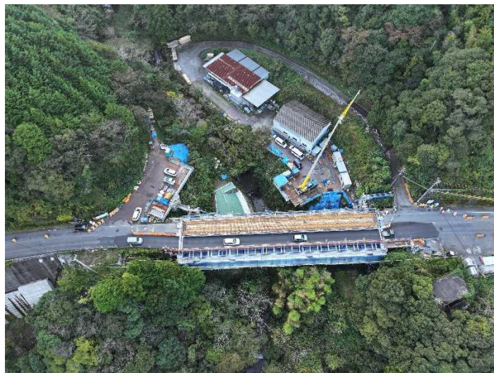
終点側工区（撮影方向：西向き）
