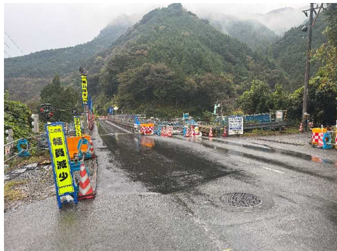
A 2 橋台側 (撮影方向：北西向き)
