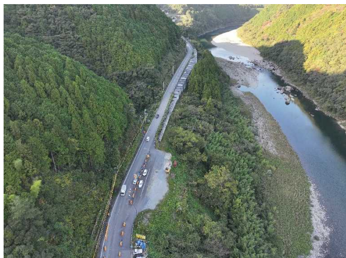
起点側工区（撮影方向：北向き）
