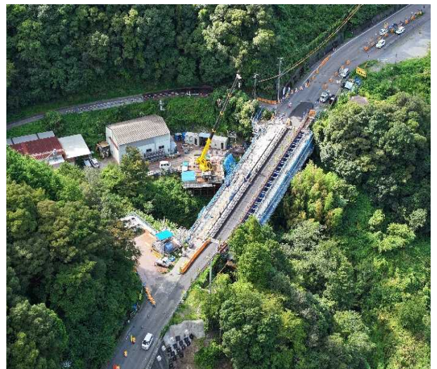
終点側工区（撮影方向：北向き）
