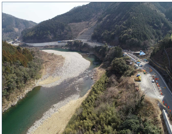
終点側工区（撮影方向：南東向き）
