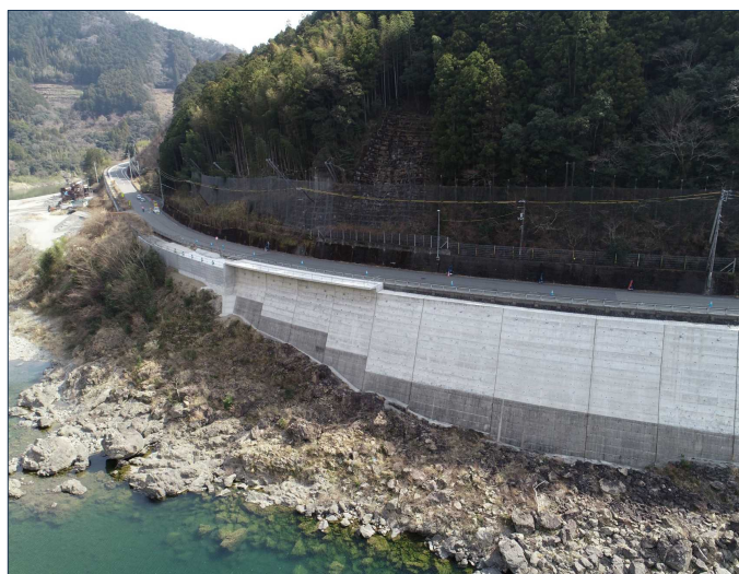
起点側工区（撮影方向：南東向き）
