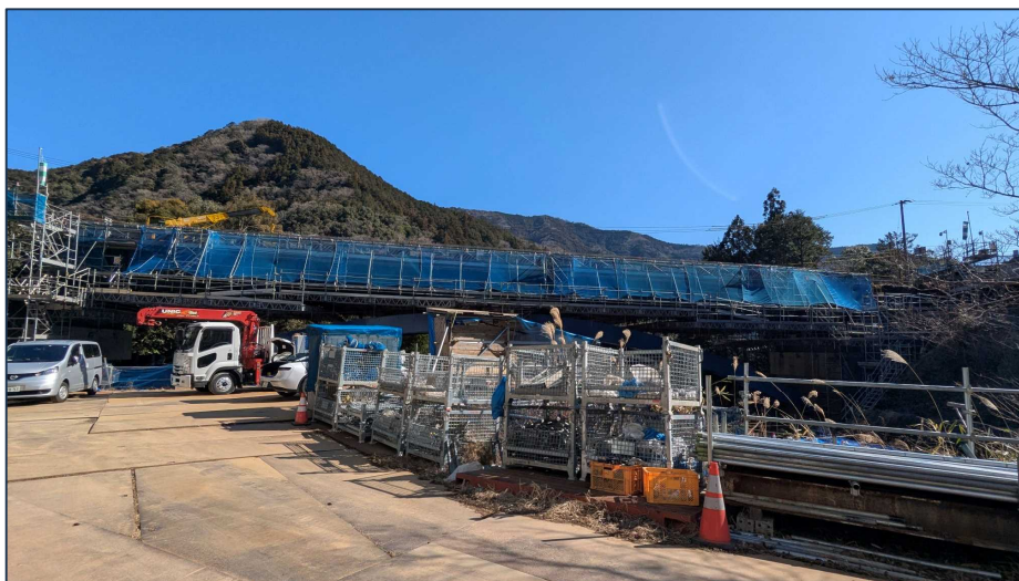
令和7年3月 現在 青漬谷川上流より（撮影方向：北東向き）
