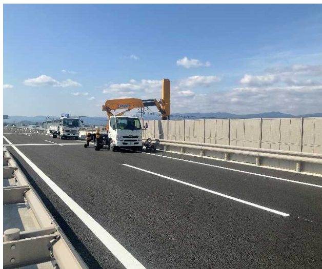
令和7年3月現在 安全施設工事を行っています。
