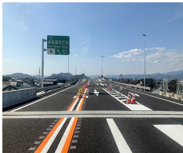
令和7年3月現在 安全施設工事をしています。
