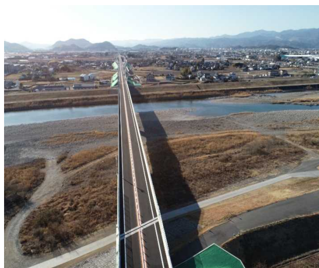
令和7年3月現在 新物部川大橋の全景です。
