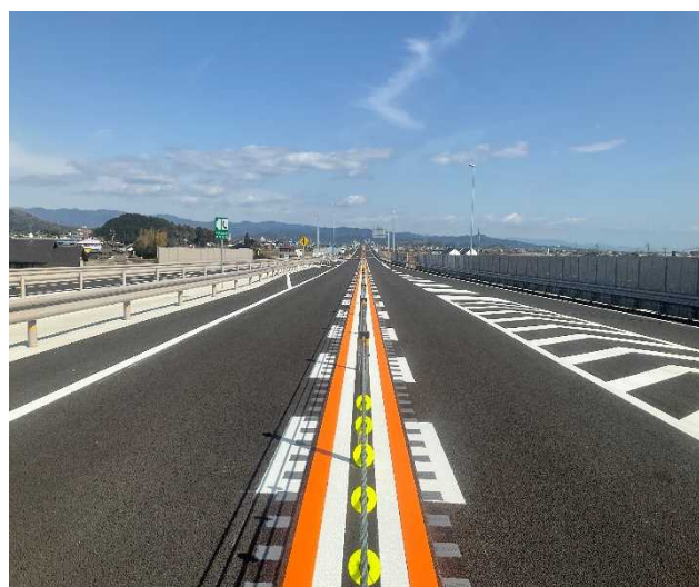
令和7年3月現在 物部地区の状況です。
