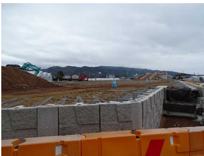
令和7年3月現在 擁壁工事を進めています。
