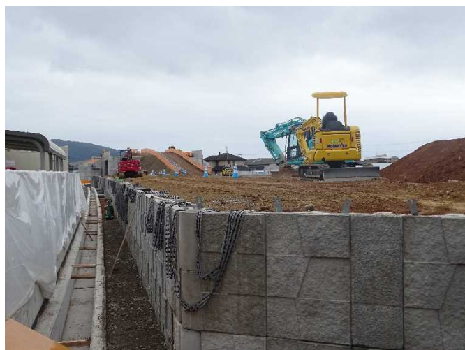
令和7年3月現在 擁壁工事を進めています。
